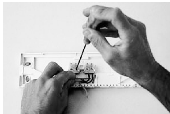
Connecter les câbles
