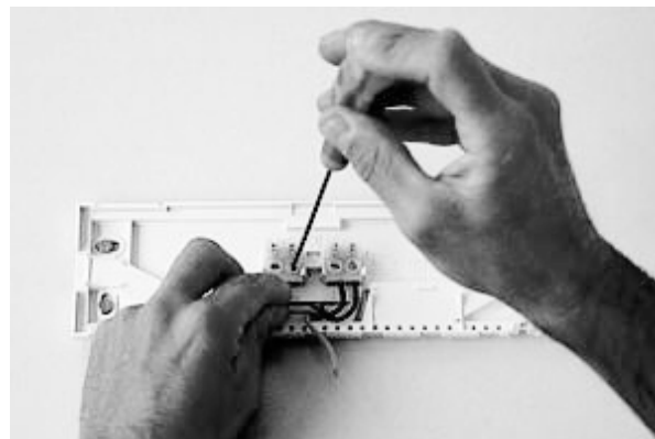
Conectar los cables
